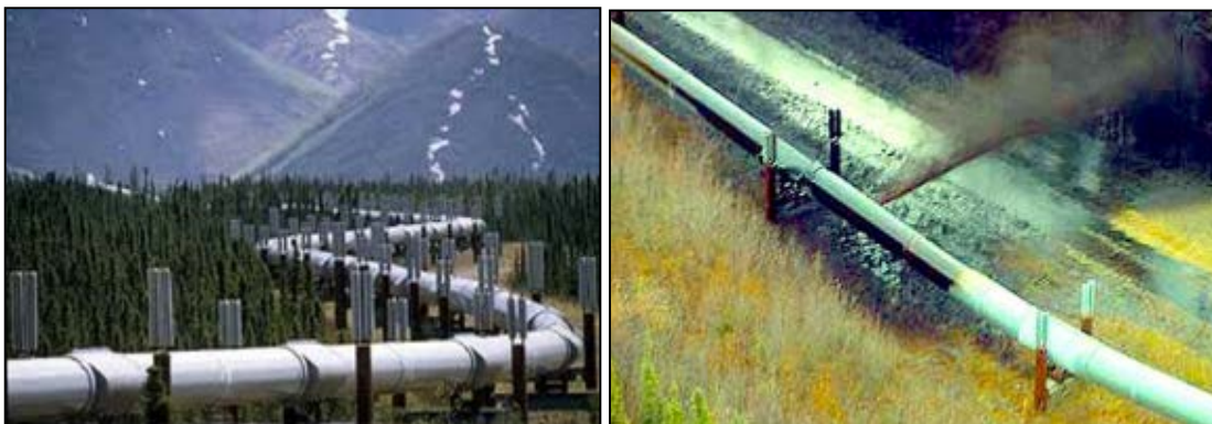
8.45. kép A végtelenbe futó alaszka kőolajvezeték, valamint egy környezetét szennyező meghibásodott vezeték szakasz 439
