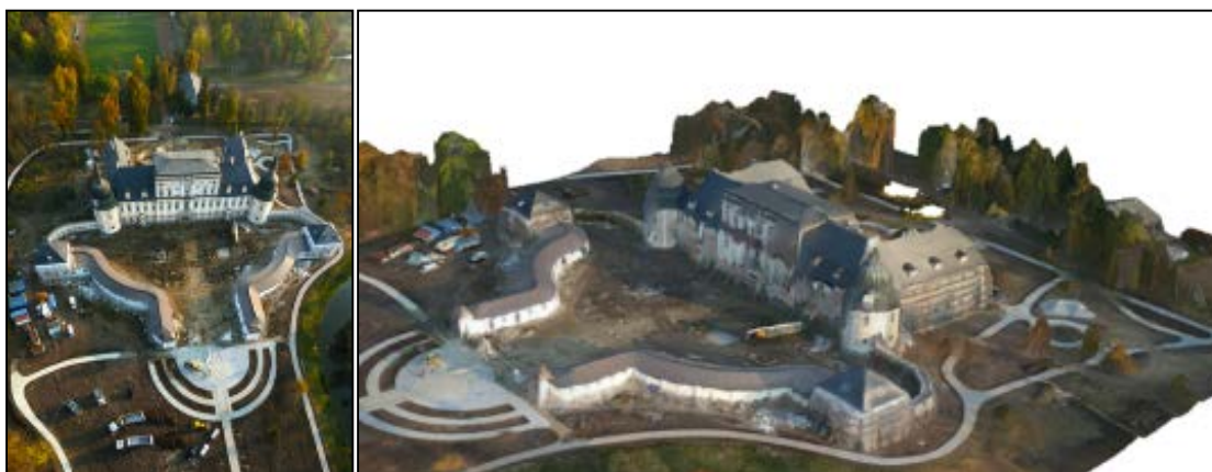
8.50. kép Az edelényi Coburg kastély felújítása során UAV-vel készített felvétel, valamint egyszerűsített 3 dimenziós képalkotás (2011) 445
